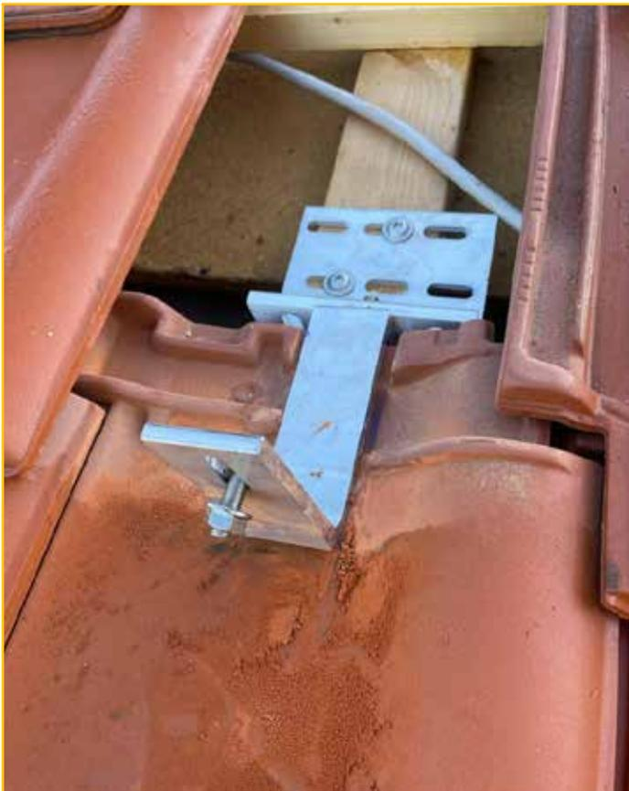
Positioniere den Dachhaken so, dass er in das Tal zwischen den Dachziegeln passt. Achte darauf, einen Mindestabstand von 5 mm zwischen dem Dachhaken und den Dachziegeln einzuhalten.
