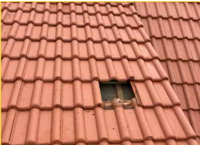
Um die Dachhaken am Dachsparren zu befestigen, beginne damit, die Dachziegel zu entfernen, die über dem Dachsparren liegen. Wenn du beabsichtigst, den Dachhaken beispielsweise an der Lattung anstelle des Dachsparrens anzubringen, ist es unerlässlich, die Statik im Voraus zu überprüfen.
