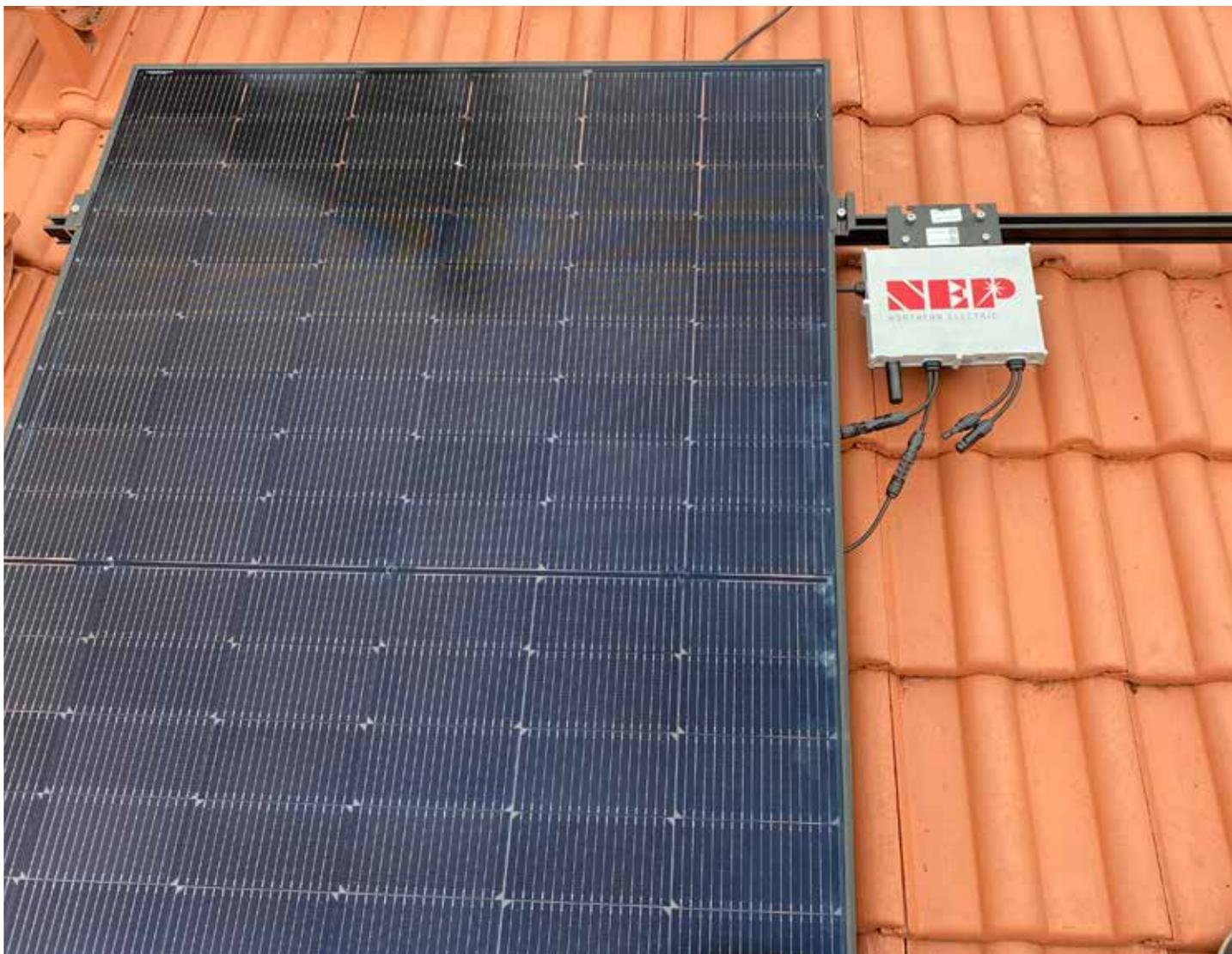
Jetzt kannst du mit den Kabelbindern die losen Kabel am Modul befestigen.
